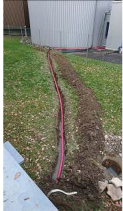
Neu verlegen der Steuerkabel
